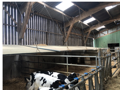
Aménagement de zone de confort: planche surplombant la case collective maintenue par des cables
